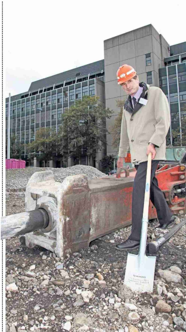
Spatenstich: Roger Beier, Leiter Development bei SBB Immobilien. AEBI
