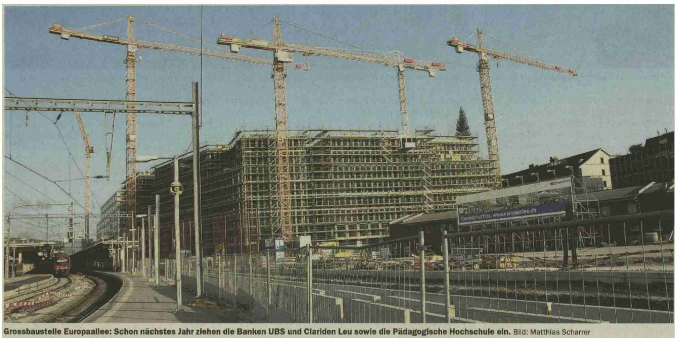
Grossbaustelle Europaallee: Schon nächstes Jahr ziehen die Banken UBS und Clariden Leu sowie die Pädagogische Hochschule ein. Bild: Matthias Scharrer
